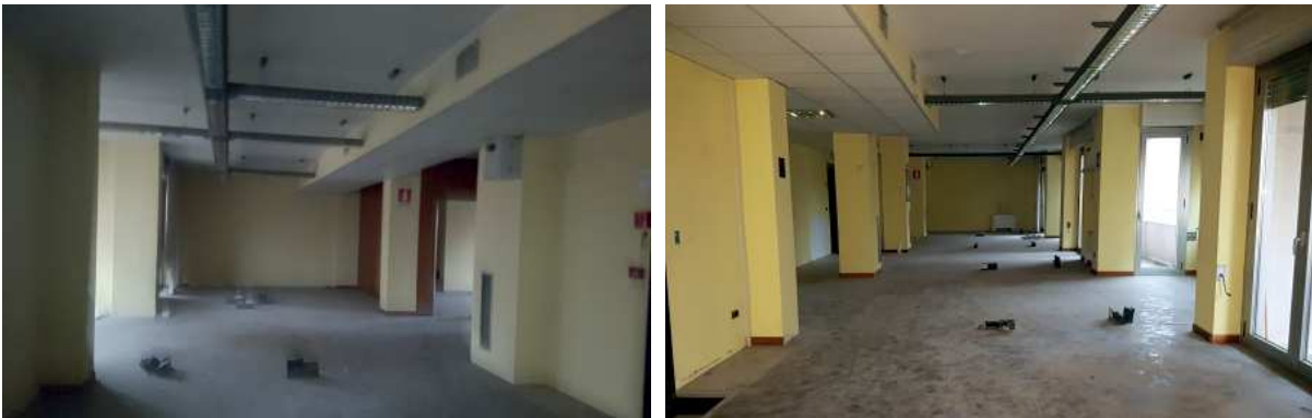
Vista interna della proprietà
