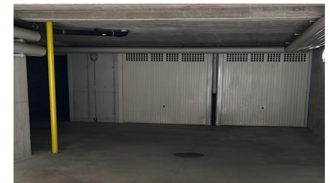
Vista interna unità
