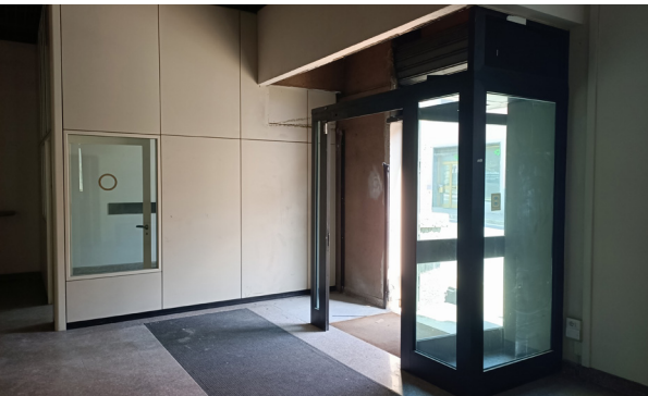
Vista interna unità commerciale/direzionale
