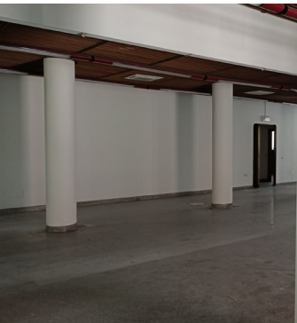
Vista interna unità commerciale/direzionale
