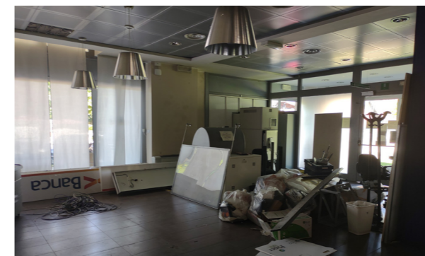
Vista interna unità commerciale
