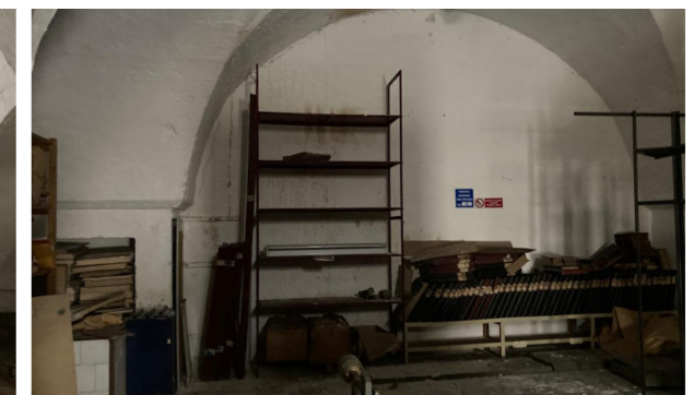
Vista interna unità ad uso deposito
