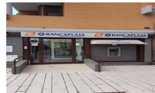
Vista esterna fabbricato
