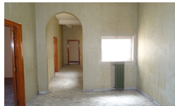
Vista interna unità residenziale
