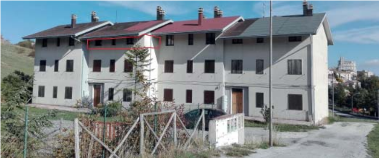
Vista esterna fabbricato
