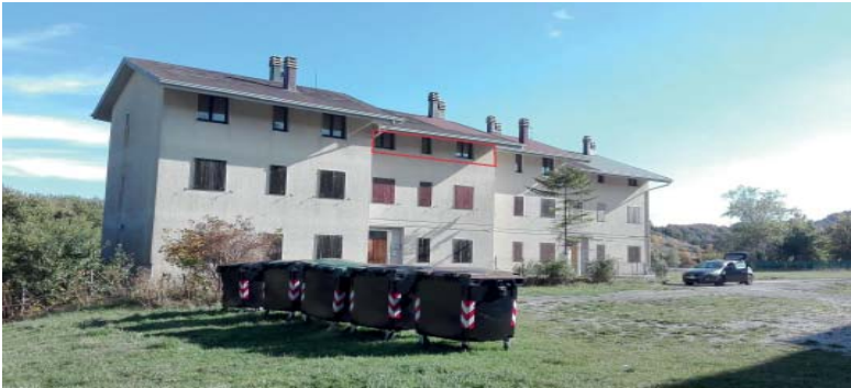
Vista esterna fabbricato
