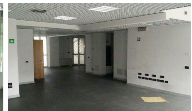
Vista interna unità commerciale
