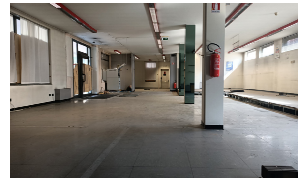
Vista interna unità commerciale/direzionale
