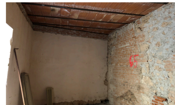
Vista interna unità commerciale
