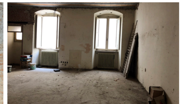
Vista interna unità commerciale
