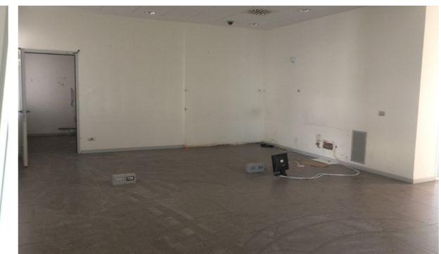
Vista interna unità commerciale
