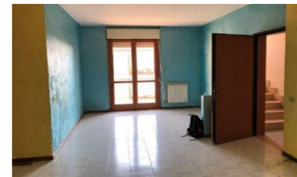
Vista interna unità residenziale
